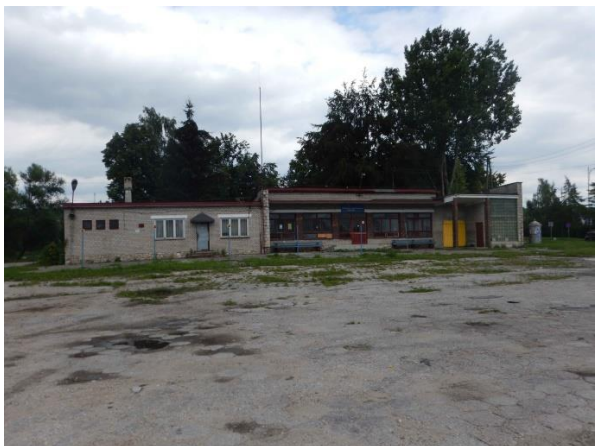
Fot. 17. Widok na dawny dworzec autobusowy w południowej części mpzp 1C. (źródło: opracowanie własne)
