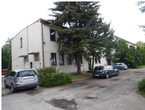
Fot. 4. Widok na budynek – siedzibę PIW w Pińczowie w północnej części mpzp 1B1. (źródło: opracowanie własne)
