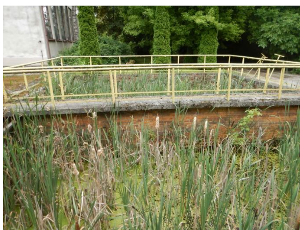
Fot. 6. Widok na nieużytkowane już urządzenia dawnego terenu ujęcia wody na terenie mpzp 1B1. (źródło: opracowanie własne)
