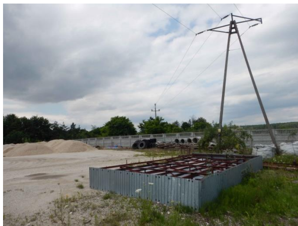
Fot. 2. Widok na miejsce składowania piasku i maszyn budowlanych w południowym krańcu mpzp 1A. (źródło: opracowanie własne)
