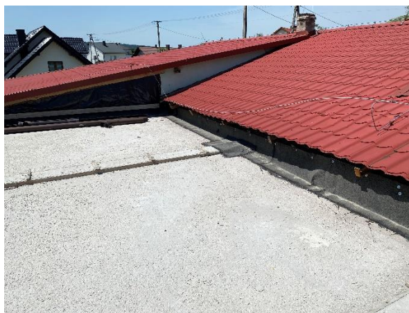
Więżba dachowa i pokrycie przed
