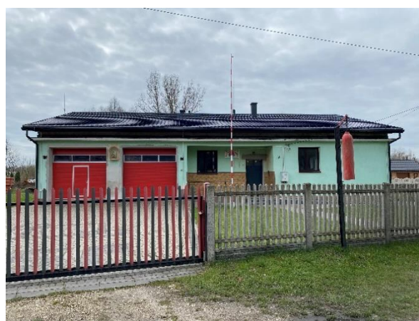
Więżba dachowa i pokrycie po
