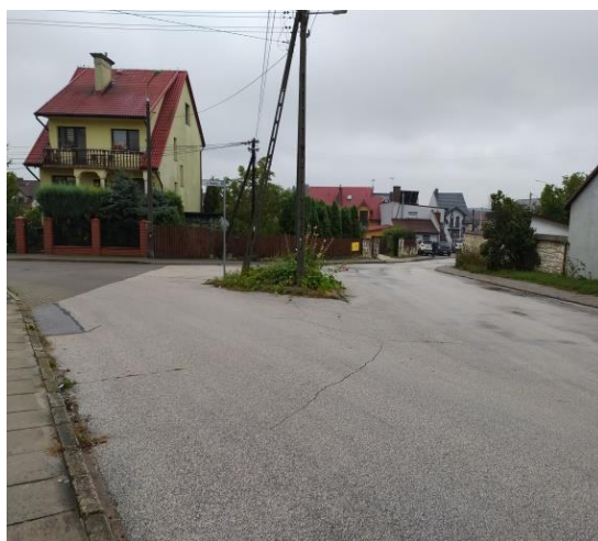
ul. Nowa (po remoncie)
