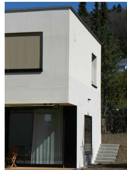
Przykład elewacji wykończonej tynkiem ryflowanym
