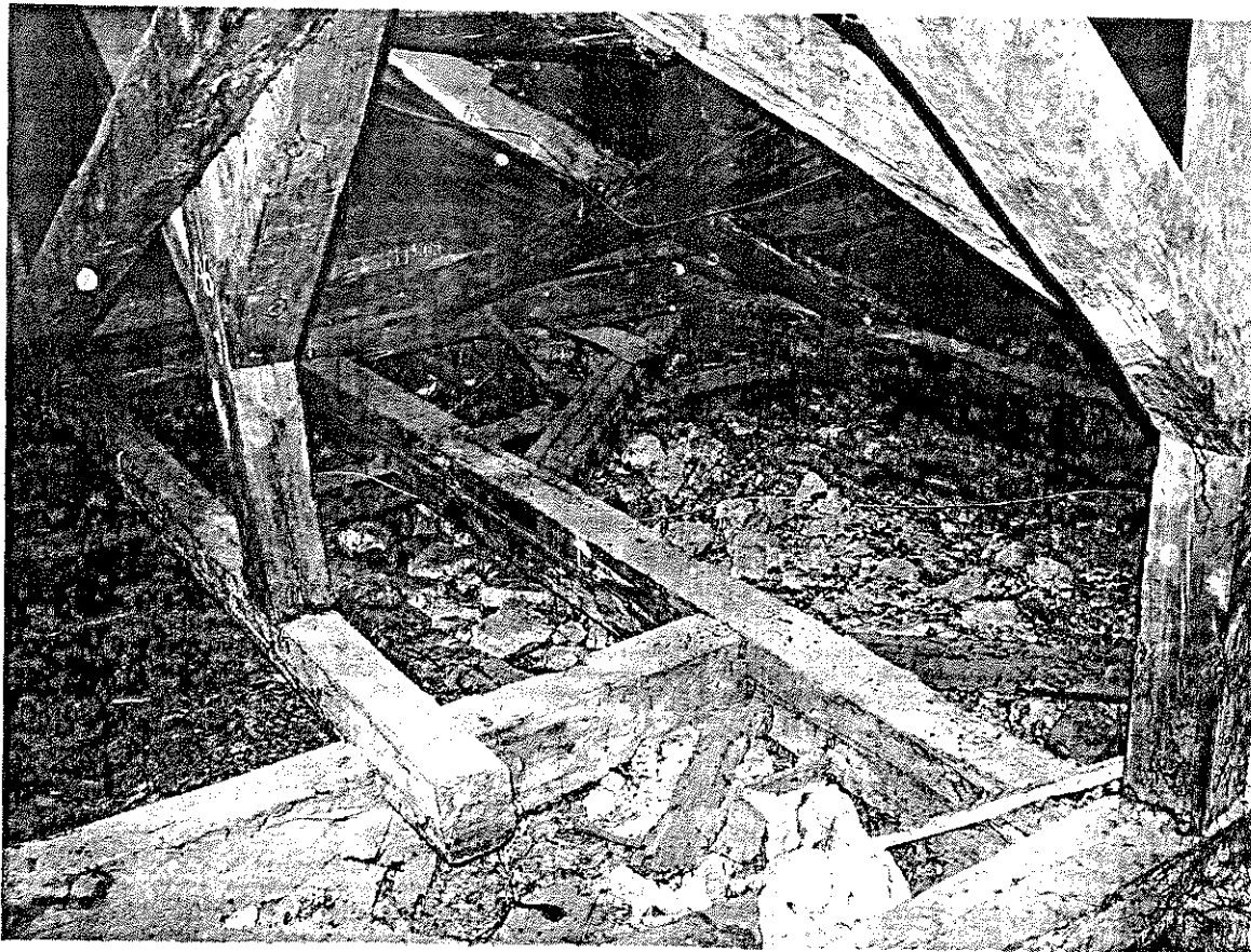
Fot. 8 – Więźba dachowa – widok belek podwlinowych.
